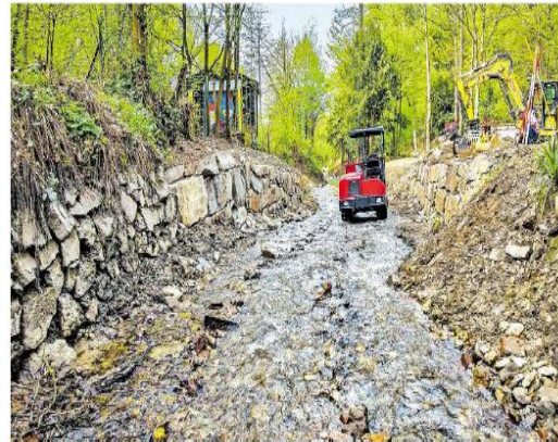
Das Wehr am Murbach wurde entfernt, der Bachlauf verbreitert.
